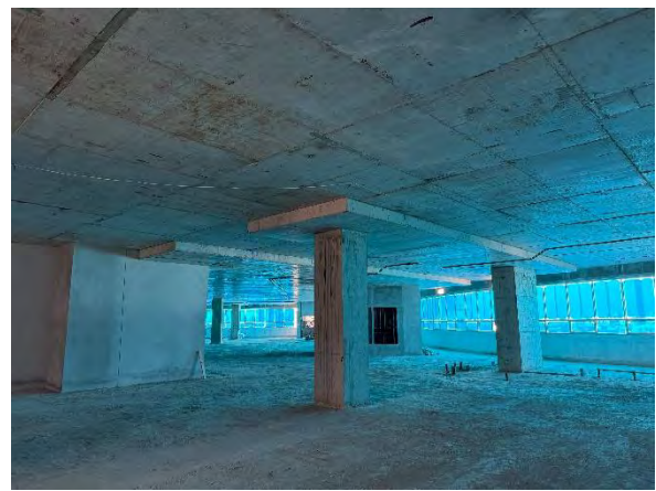
(d) PT slab with column head
