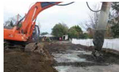
In-situ cement stabilisation
