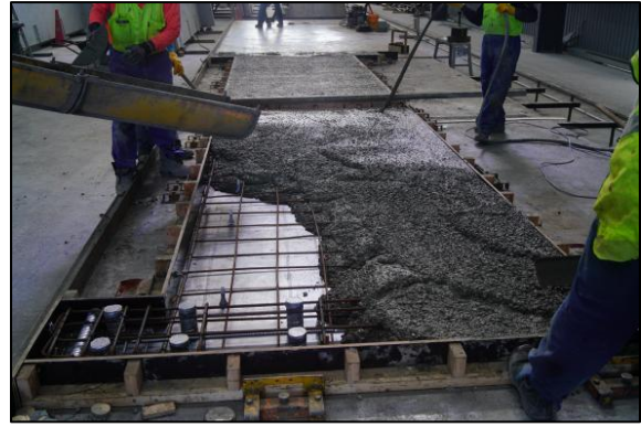
(b) Pouring concrete
