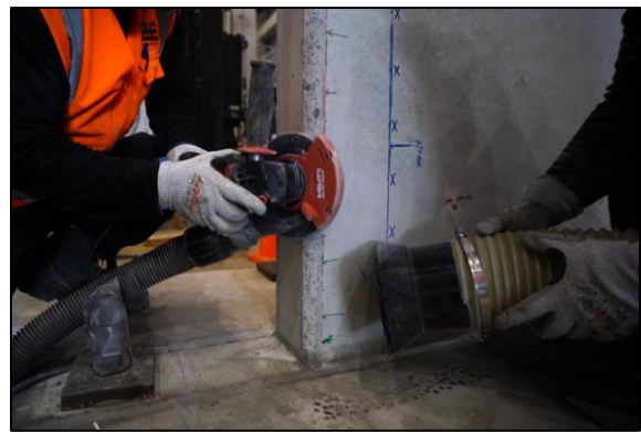
(d) Grinding for rounded corners before wrapping FRP
